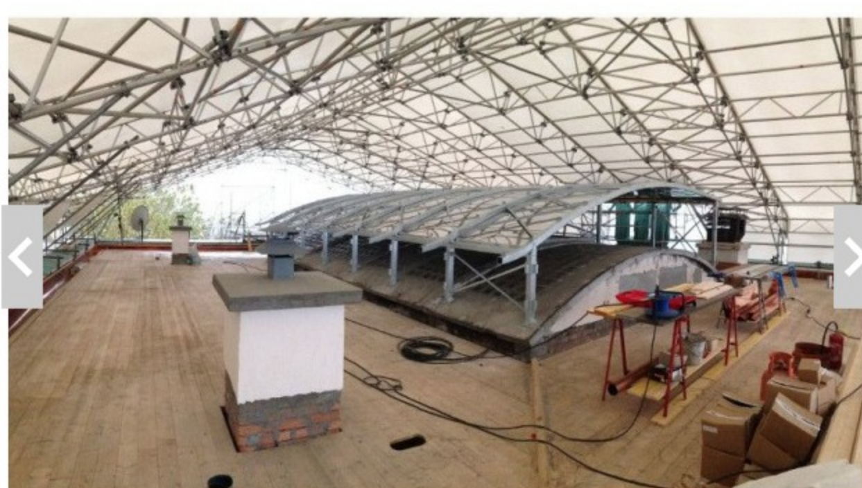
Ambassade de France en Serbie, chantier de la toiture centrale © ARC&SITES
